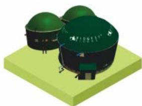
**Реактор анаэробного сбраживания** – сооружение, в котором происходит процесс брожения и разложения биомассы под влиянием метанобразующих бактерий, выделение биогаза и преобразование биомассы на биоудобрение
